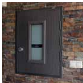
Ochrana elektroměru, bezpečnostní třída 3
