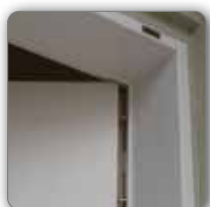
ADLO Nutdichtung in einer Thermo-Türzarge
