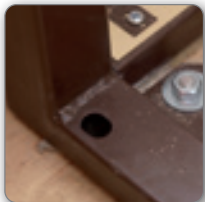
Protikus spodního uzamykání
