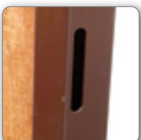
Protikus hlavního uzamykání
