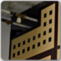
Přizpůsobení rozvodům ve sklepe
