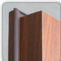
ADLO drážkové těsnění ve falci dvevního Termo křídla
