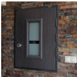
Ochrana elektroměru, bezpečnostní třída 3
